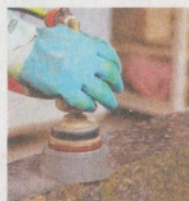
Eine alte Grabeinfassung wird abgeschliffen.
